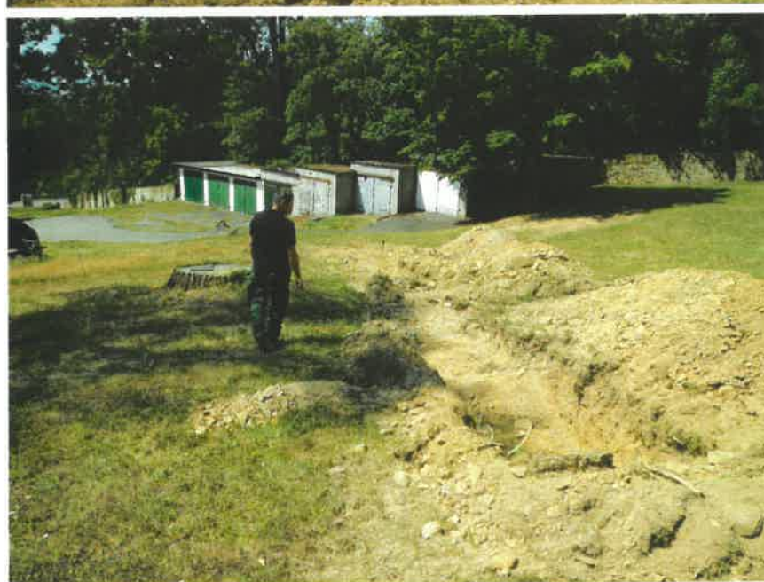
Sondierungen wurden aufgrund der Einlagerungen im Erdreich erweitert, Nr. 3
