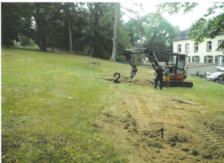
Sondierungen im Abstandsstreifen U1,
